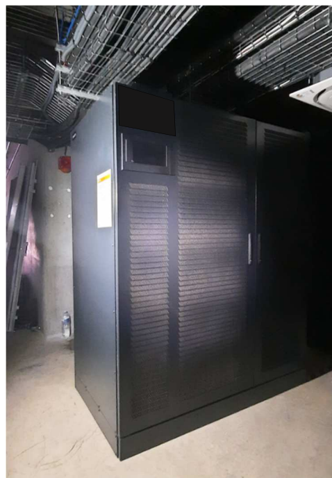
Photographie 12: système d'alimentation sans interruption (ASI) similaire à celui impliqué dans l'incendie
